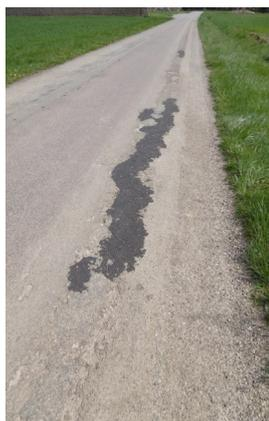
**29 Mars: Rebouchage de trous dans la chaussée avec de l'enrobé à froid par Pascal, Pierre et Olivier.**
